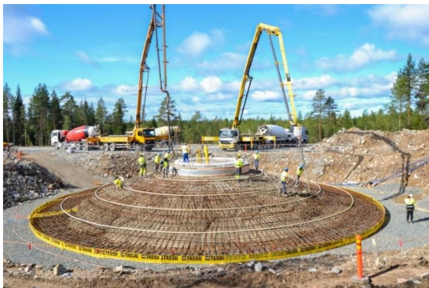
4.3.2. attēls. VES būvniecība (ilustratīvs attēls) 29
