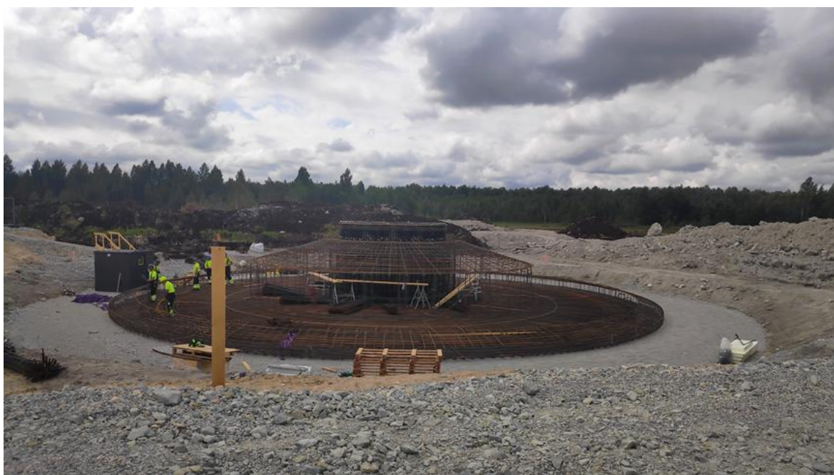
4.3.7. attēls. VES pamatu konstrukcijas metāla konstrukciju daļa darba procesā (foto: Enviroprojekts, Igaunijā, 2023)
