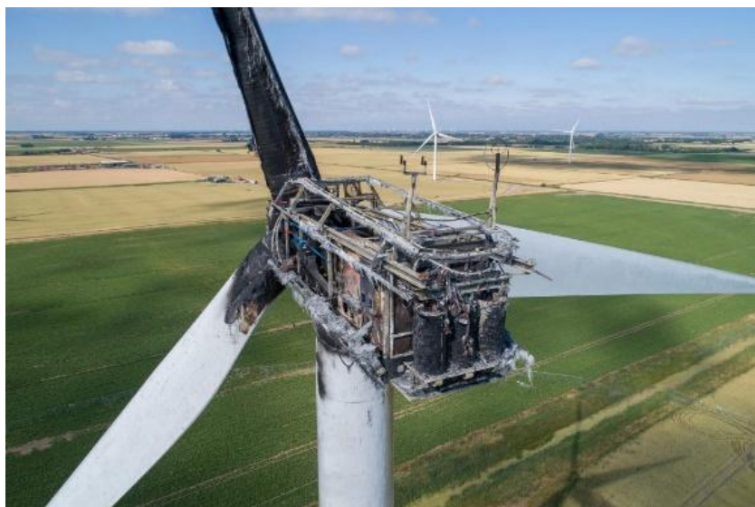
5.3.9. attēls. VES bojājumi, ko izraisījis ugunsgrēks. 101
