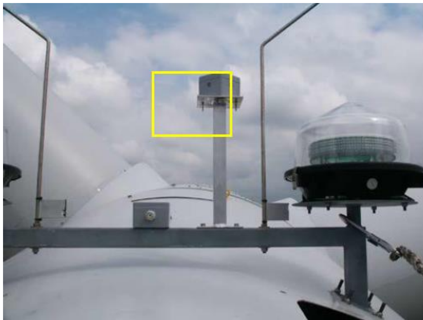
7.3.1. attēls. Virs VES gondolas uzstādīts gaismas sensors ēnas mirgošanas novēršanai (avots: SIA “Ventspils Wind” vēja elektrostaciju būvniecības Tārgales pagastā, Ventspils novadā, ietekmes uz vidi novērtējums, SIA “Vides eksperti”, 2022)
